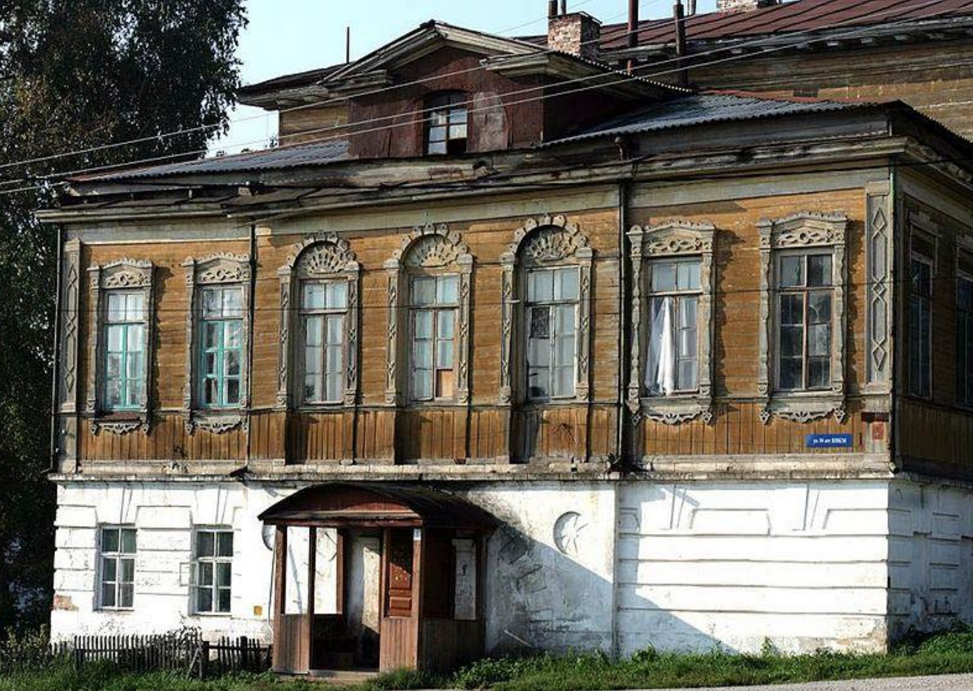
Поселок Дубна Тульской области. Ансамбль промышленной усадьбы Мосоловых. Главный жилой дом
